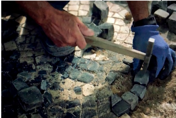
Figura 2 – O trabalho de calceteiro: ajustamento da pedra ao molde
